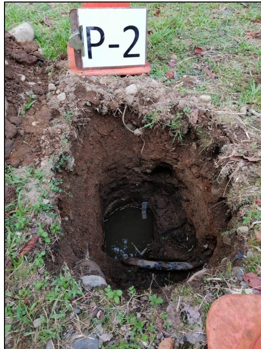
Fotografía. Vista de prueba INF-2.
