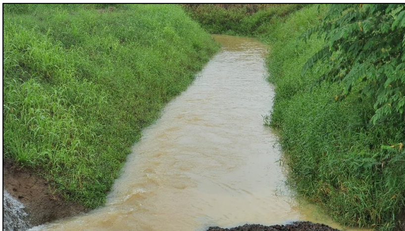
Sector aguas abajo del paso de la quebrada en el sector sur del lote
