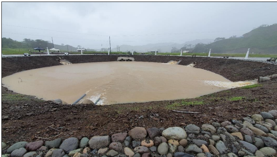
Figura 4.1. Rotonda/laguna de recolección de aguas pluviales ubicada en el sector norte del AP
