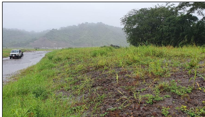
Dique de protección existente en la margen derecha de la quebrada
